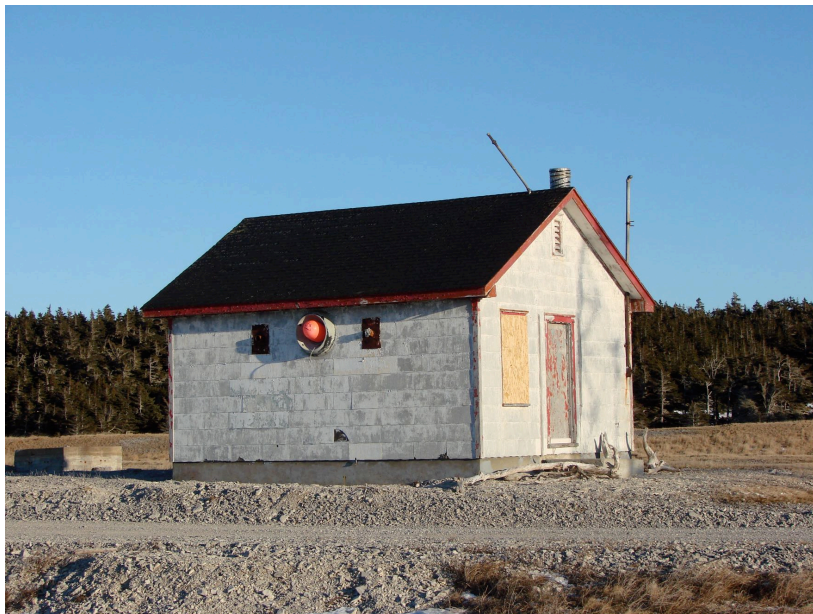
ancienne cabane à génératrice de la Pointe-Ouest
