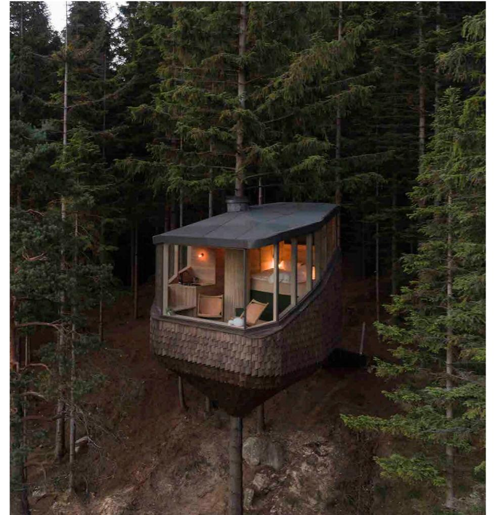
Le projet de Woodnest Cabin démontre une intégration harmonieuse avec la forêt grâce à une construction autour d'un tuyau d'acier qui embrasse un tronc d'arbre et permet de limiter l'emprise au sol et ses impacts sur l'environnement. De plus, ce positionnement en hauteur offre une expérience unique au visiteur, rappel à la cabane dans les arbres, tout en offrant des vues vers l'horizon.
